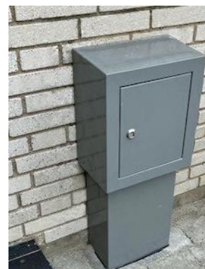
Ventilskab uden på ejendom
